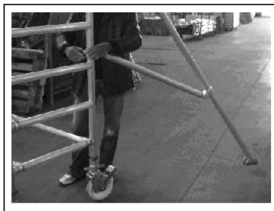
Fot.17: Montaż stabilizatora
