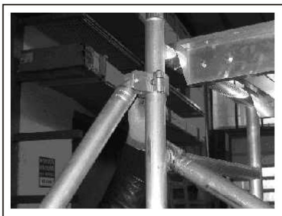
Fot.17: Montaż stabilizatora
