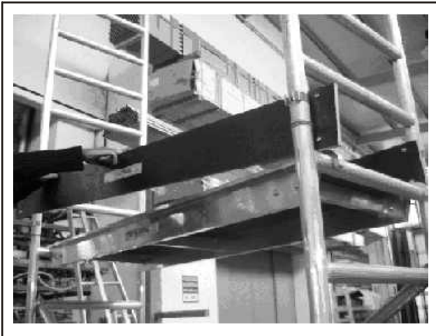
Fot.20: Montaż burt zabezpieczających
