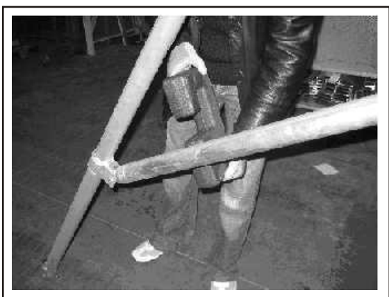
Fot.18: Montaż balastów
