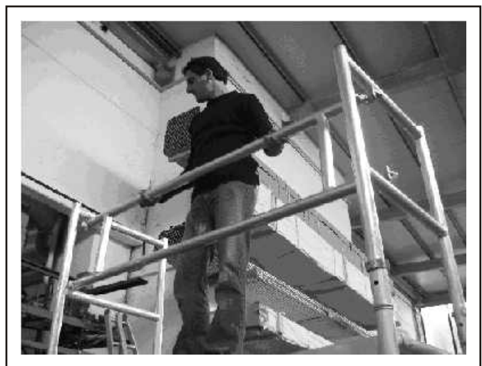
Fot.26: Montaż bocznych barierek zabezpieczających
