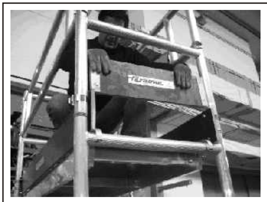
Fot.27: Montaż burt zabezpieczających
