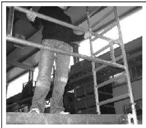
Fot. 21: Montaż barierki zabezpieczającej
