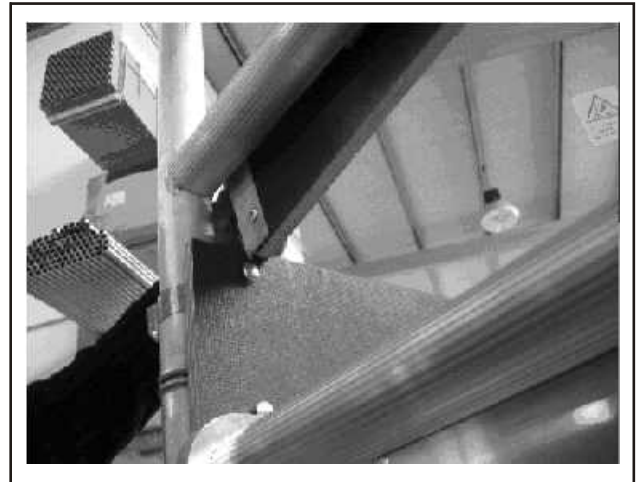
Fot.20: Montaż burt zabezpieczających
