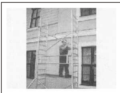
Fot.23: Montaż poprzeczek ukośnych
