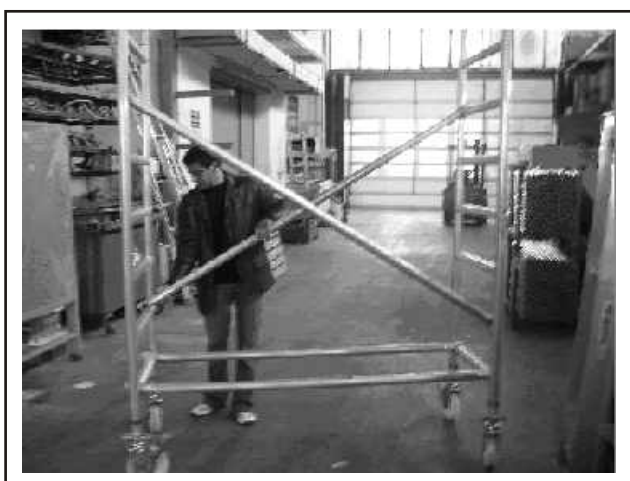
Fot.11: Montaż poprzeczek ukośnych
