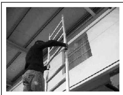
Fot.22: Montaż ram bocznych
