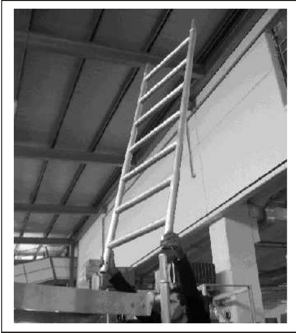
Fot.19: Zakładanie ram bocznych
