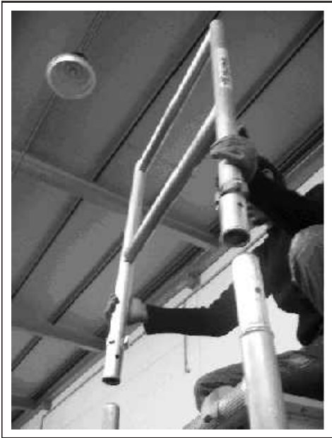
Fot.25: Montaż wieńczących ram bocznych
