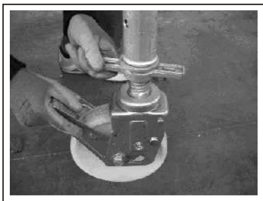
Fot.13: Wyrównanie ustawienia rusztowania jezdnego
