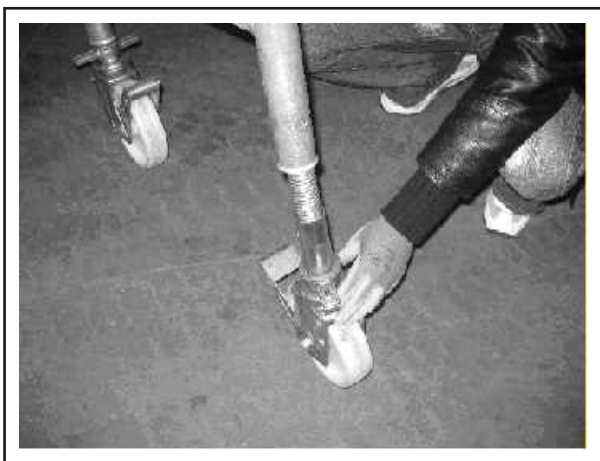
Fot.7: Nakładanie kółek
